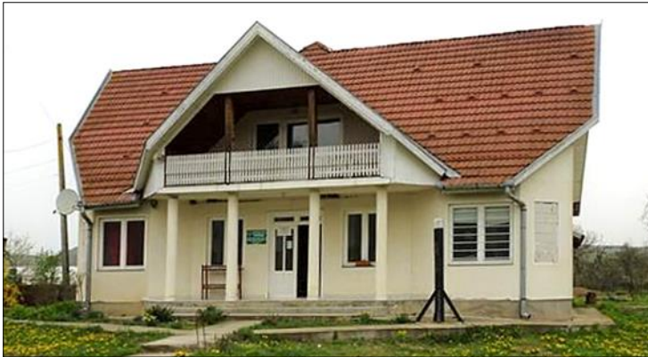
Het nieuwe gebouw, geopend oktober 1999. Rechts vooraan de meerpaal
