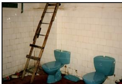
De nieuwe blauwe toilet potten
