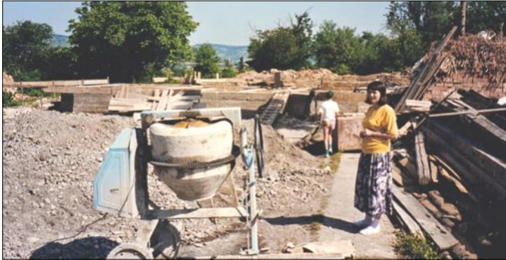
Magdalena, de vrouw van de predikant Inspecteert de bouw
