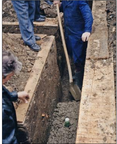
In de fundering wordt een fles champagne geplaatst
